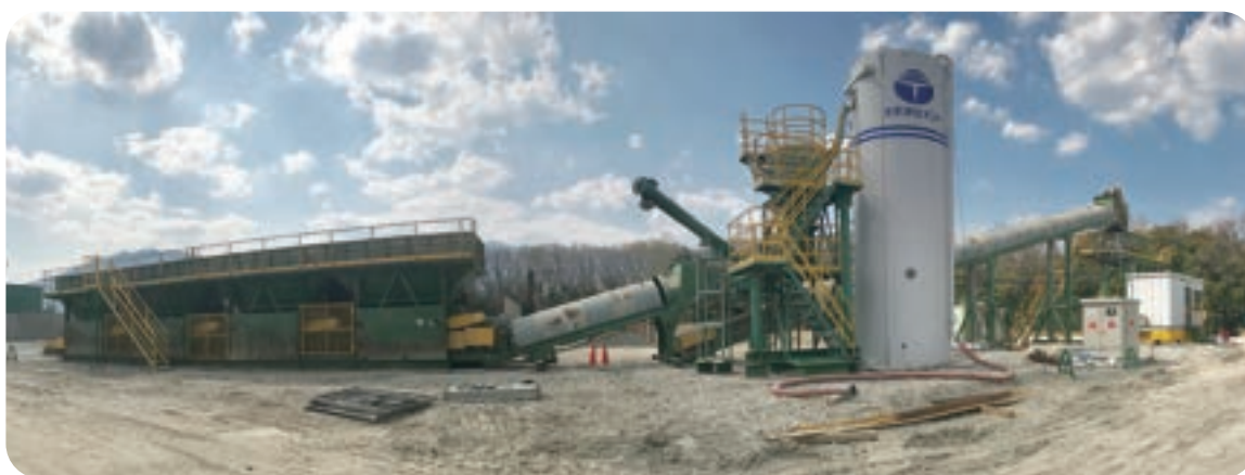
ソイルプラントの組立・解体及び運送
