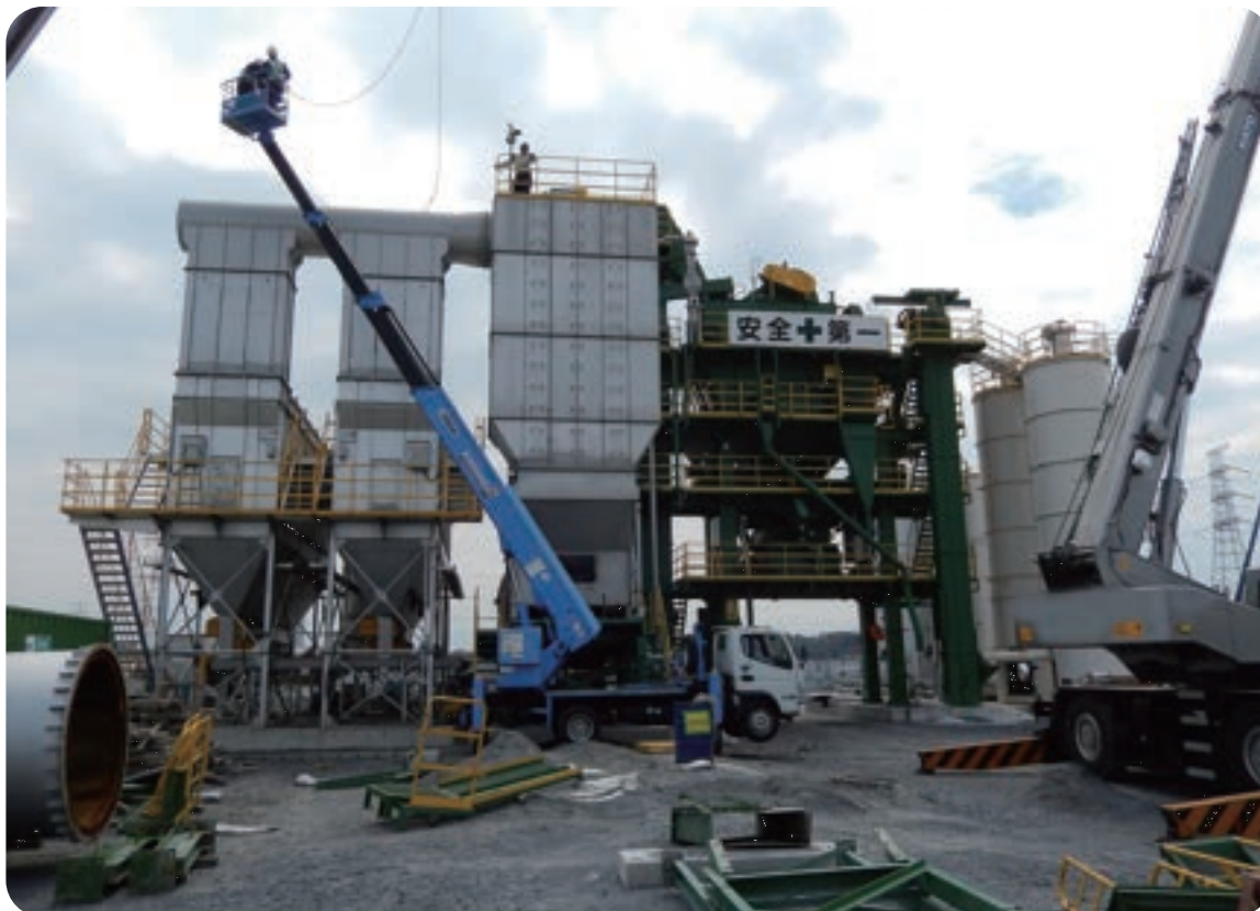
アスファルトプラントの組立・解体及び運送
